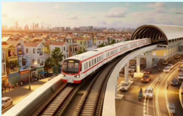
Dự án Metro số 2 Thành phố Hồ Chí Minh (Bến Thành - Tham Lương)
